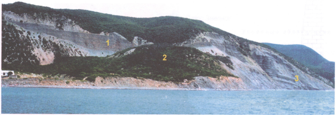
Рис. 3. Участок побережья юго-восточнее мыса Б. Утриш. На фото видны плоскость срыва обвала-оползня (1), оползневой блок (2), участок берега, сложенного коренными породами (3)
