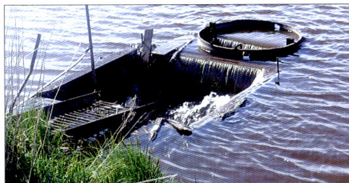
Верховой водосброс из пруда на малом притоке в р. Ишим (Абатский район Тюменской области)
