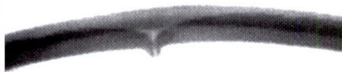
Рис. 8. Дефектный участок шва (отсутствие перекрытия)
