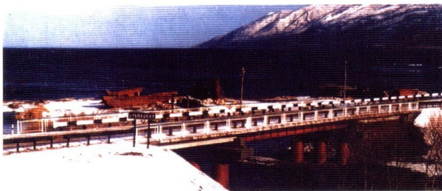
Мост через р. Рыбацкая, введен в эксплуатацию в 1996 г.
