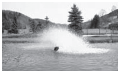
Рис. 56. Лоп стно-колёсные эр торы «AQUA-Wheel»
